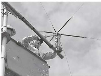
↑残ったラジアル部分とコネクタ部分の撤去を行う。しかし、腐食してなかなか外すことができない。結局、ボルトを破壊して外すことにした。
