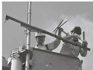
↑サイドアームに付いているショートボールが完全に錆びていて、このままでは使うことができない状態だ。取り敢えず撤去することにした。
