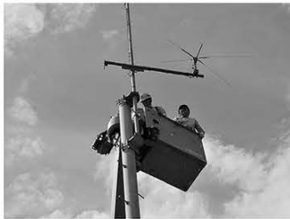
↑破損したエレメント部分を取り外し、ラジアル部分が残った状態。この後、取り付け金具を外し、コネクターを外してラジアルを撤去する。
