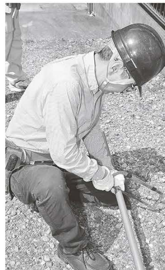
↑撤去したショートボールは腐食が進み使えないので、急速、37φのアンテナボールを金ノコで切断してショートボールを作製した。
