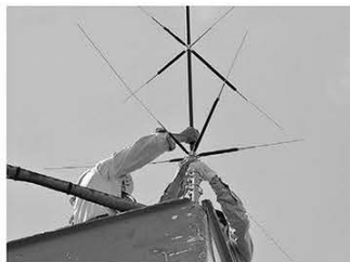
↑台風の強風でも耐えられるよう、しっかりとボルトで設置作業を行う様子。2人がかりで、確実に頑丈にボルトを締めて固定する。
