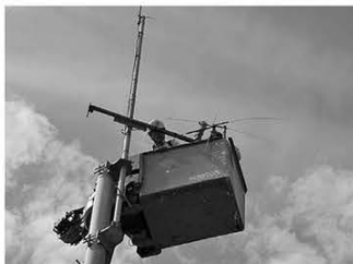
↑破損した CPVU8 のラジアル部分を撤去作業中の状態。腐食が進み取り外しが困難なので、作業カゴの内部で作業をする。
