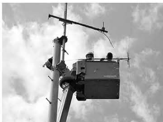
↑高所作業カゴで下から引っ張り上げた、新しい CPVU8 を受け取った状態。この後、このアンテナをサイドアームに設置する。
