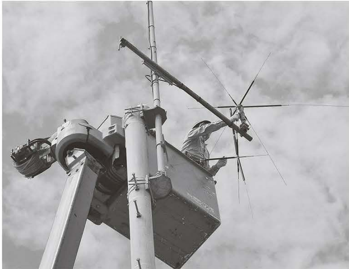
↑破損した CPVU8 の状態を確認する相磯さん。「銅線 1 本で垂れ下がっている状態だ!」と早く撤去しないと危険だということを指摘した。
