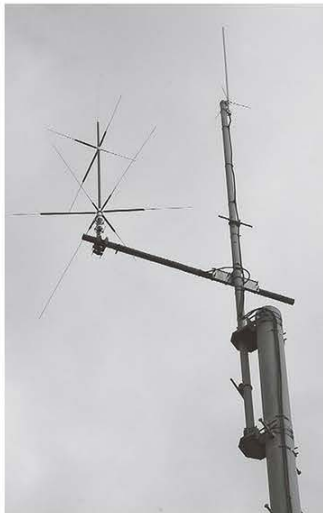
↑新しいアンテナを設置した鋼管ボールのトップ部分。これで台風の強風を心配せずにアマチュア無線を楽しむことができるのだ。
