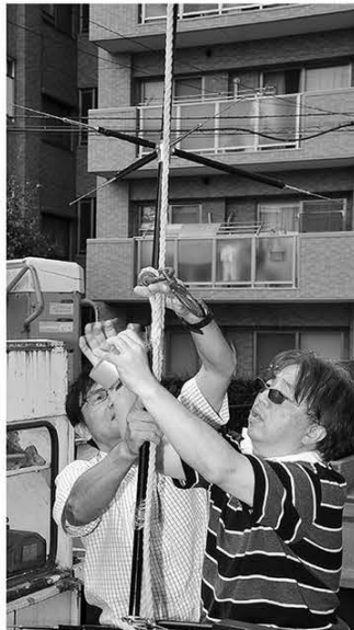
↑新品の自分で組み立てた CPVU8 を、高所作業カゴから垂らしたロープに、手伝いに来てくれたローカル局と二人で括り付ける。
