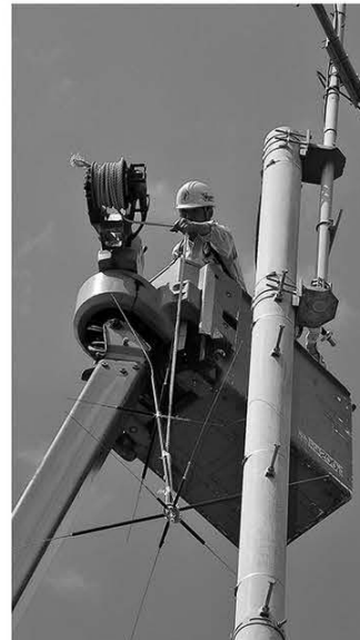
↑ウィンチとロープを上手に手繰りながら、高所作業カゴからアンテナを引っ張り上げていく。アンテナを傷つけないよう慎重に作業している。
